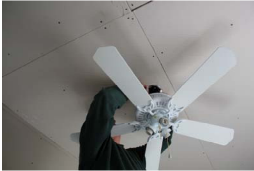
Installing a ceiling fan
